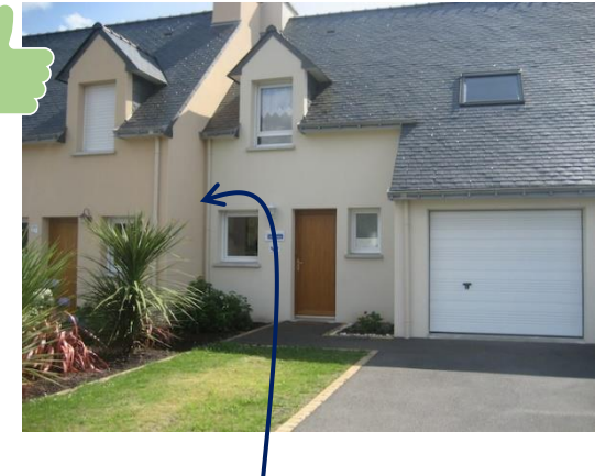
Décalage des façades
