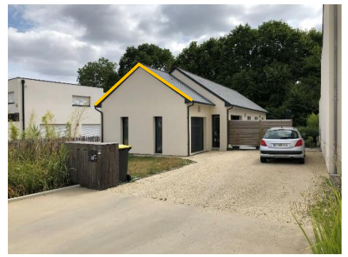
La toiture à deux pans
