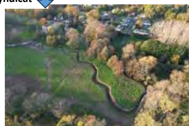
Restauration de la continuité écologique au moulin de Moquesouris, à Nazelles-Négron
